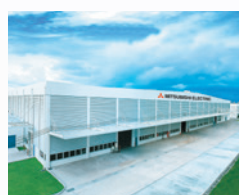
Usine de Chonburi en Thaïlande
