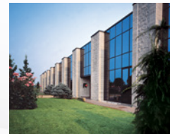
Usine de Pavie : IT Cooling
